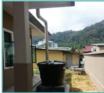
Takungan air hujan
